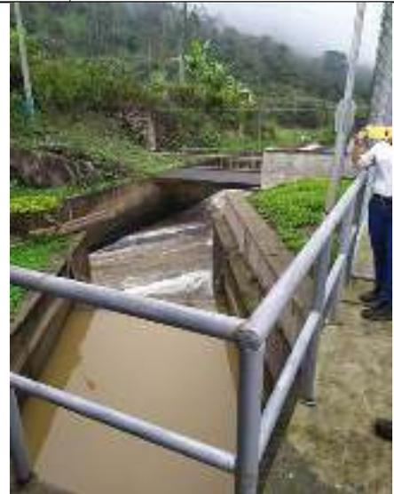
**Fotografía 9.** Salida de agua de la casa de máquinas (devolución del agua)
