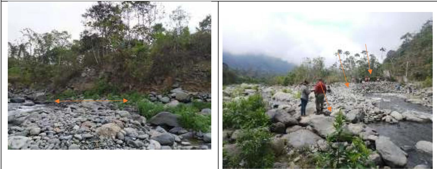
**Fotografía 2.** Inicio del sitio de la toma de captación de agua, que servirá como caudal ecológico, en el tramo que se afecta. Inicio del muro de piedra que desvía el cauce natural del río Dulcepamba hacia el proyecto Hidroeléctrico San José del Tambo
