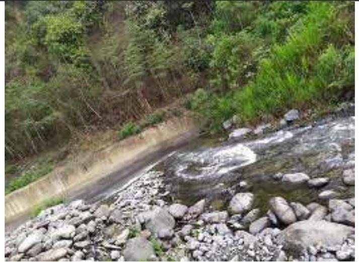
**Fotografía 5.** Ingreso del agua del río Dulcepamba hacia el proyecto Hidroeléctrico San José del Tambo, dicho muro cubre en la totalidad el ancho del río.
