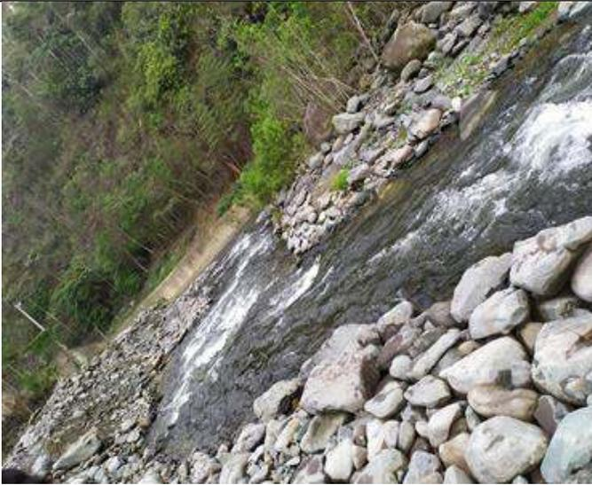
**Fotografía 4.** Muro de piedra que desvía el cauce natural del río Dulcepamba hacia el proyecto Hidroeléctrico San José del Tambo, dicho muro cubre en la totalidad el ancho del río.
