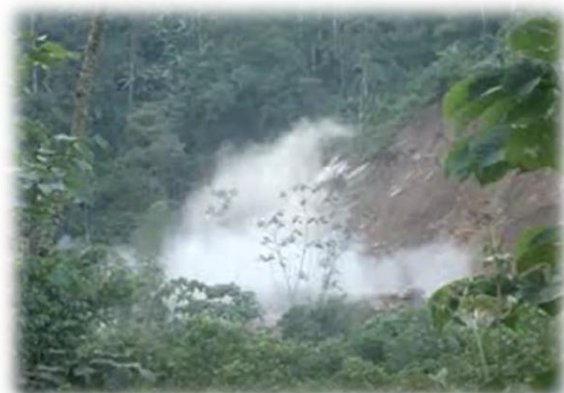
Fig. 5: 23 de julio, 2013. Ejemplo de dinamita usada durante meses por Hidrotambo S.A. en la margen derecha del río Dulcepamba
